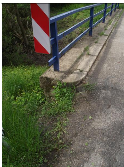
Detail napojení konce římky na terén u opěry OP2 vpravo.
