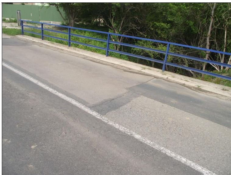
Detail napojení konce římky na terén u opěry OP2 vpravo.
