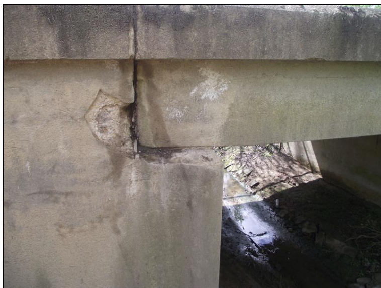
Detail uložení na levé straně opěry OP2
