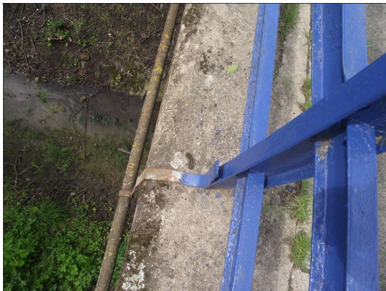
Nevhodné připevnění chráničky ing. sítě na pravé straně mostu.
